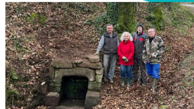
ciation de réinsertion ILOZ (basée à PIPRIAC), a accepté de nous accompagner sur ce projet. Pendant 1 mois et demi, des ouvriers travaillaient sur la rénovation et le déplacement (de quelques mètres) de ce four à pain. Ils ont enlevé puis remonté les pierres une par une pour obtenir un résultat incroyable.
